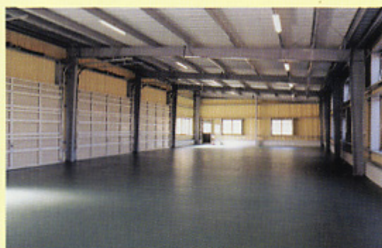
センター内部
