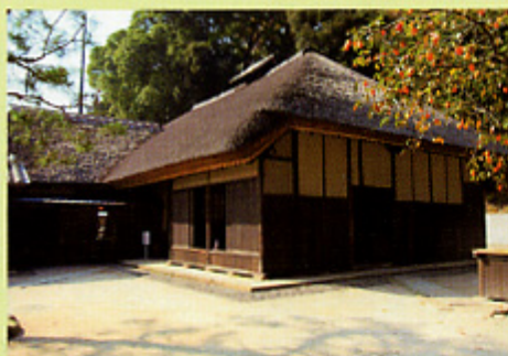
修復された茅葺きの主屋
